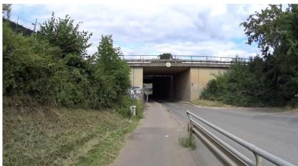
**Bild 9:** Östliche Zufahrt zur Unterführung A 3 – Ende Schutzeinrichtung (bauliche Trennung zur Fahrbahn mit Hochbord)
