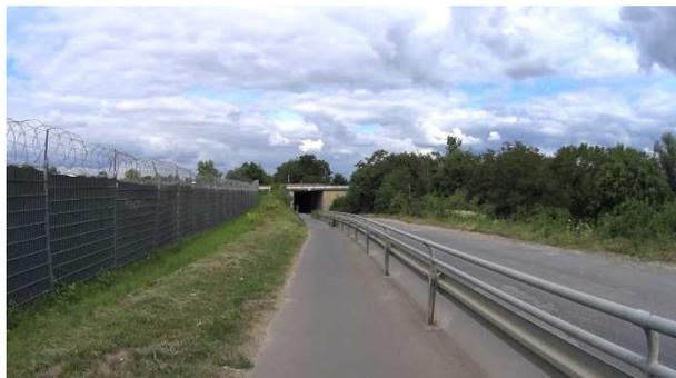
**Bild 6:** Östliche Zufahrt zur Unterführung A 3 – Schutzeinrichtung als bauliche Trennung zur Fahrbahn
