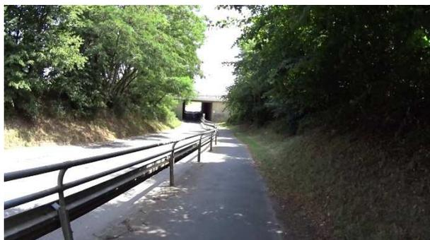
**Bild 8:** Westliche Zufahrt zur Unterführung A 3 – Schutzeinrichtung als bauliche Trennung zur Fahrbahn
