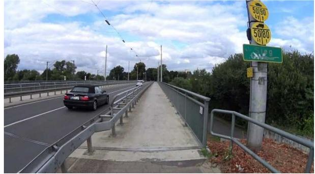
**Bild 3:** Siegbrücke Frankfurter Straße – Schutzeinrichtung als bauliche Trennung zur Fahrbahn
