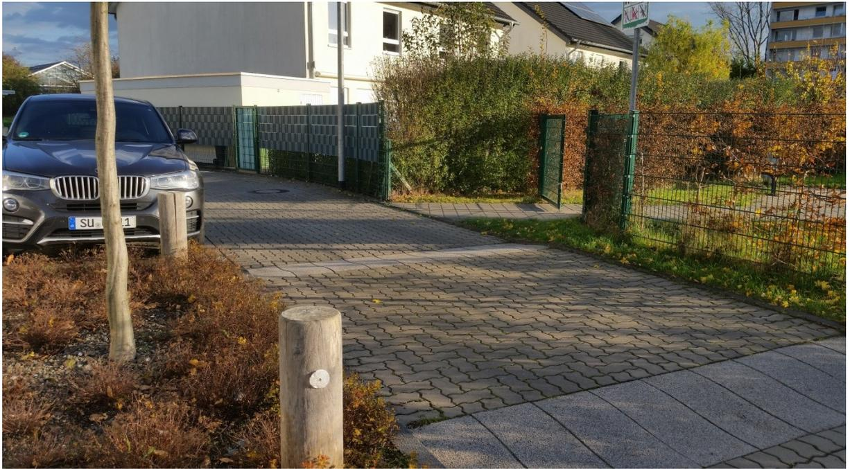
Bild 3 Fahrbahn mit Aufpflasterung
