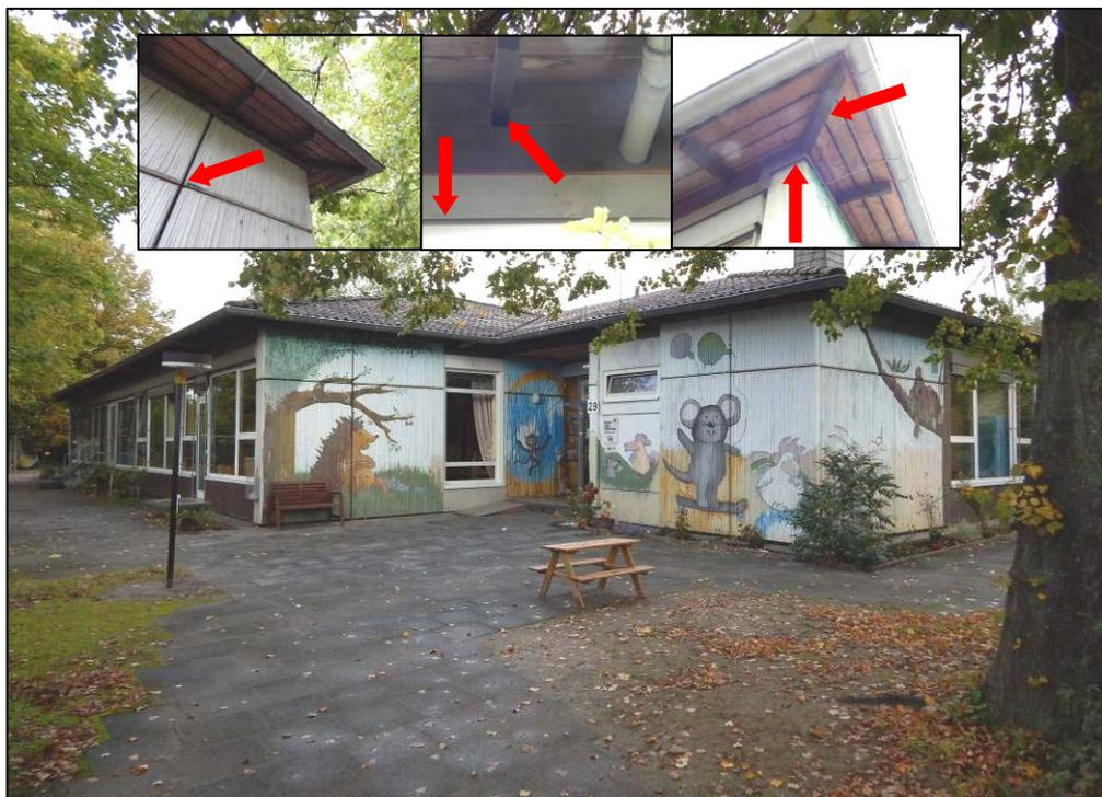
**Foto 6:** Südfassade Kindertagesstätte. Am Dachüberstand sowie an einigen Fassadenteilen des gesamten Gebäudes befinden sich Spalten und Einschlupfmöglichkeiten für Fledermäuse.
